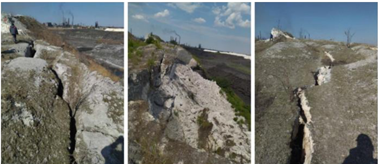
Рис. 3. Прояви небезпечних інженерно-геологічних явищ (обвали, зсуви та розтріскування потужного шару фосфогіпсу) на північній дамбі хвостосховища «Дніпровське» [3]
