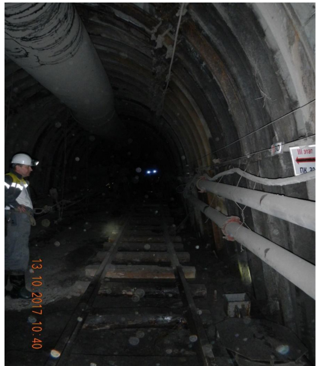
Рис. 4. Загальний вигляд конвеєрного квершлагоу, проведеного з тампонажем закріпного простору, на шахті «Героїв Космосу»
